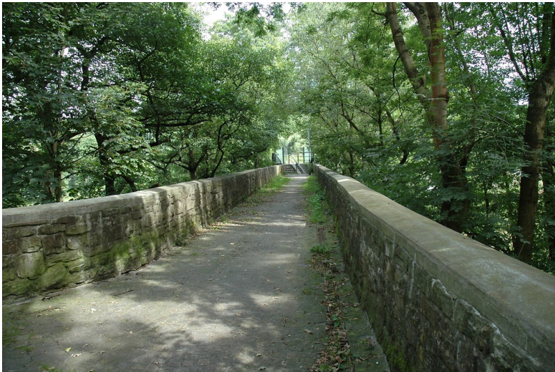
Hundebrücke in Kupferdreh Fotograf/Urheber: Buchholz, Karl-Heinz
