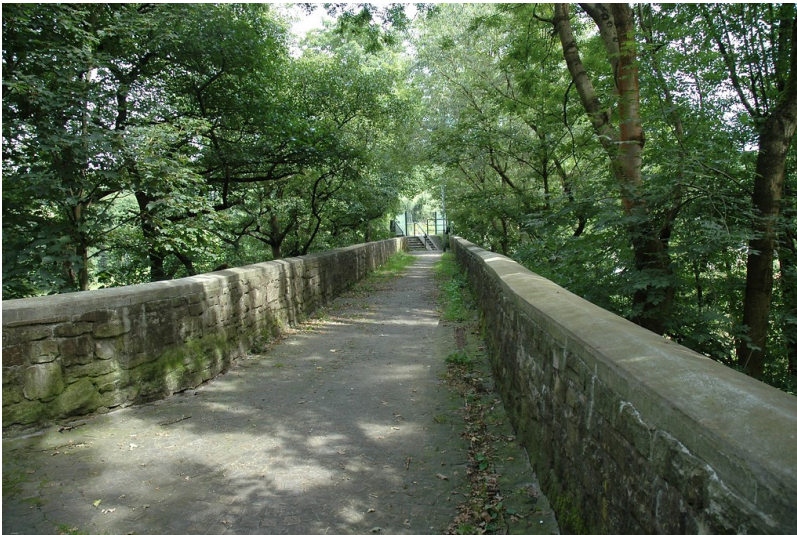
Hundebrücke in Kupferdreh Fotograf/Urheber: Buchholz, Karl-Heinz
