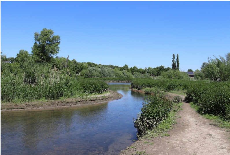
Renaturierungen der Wurm zwischen Geilenkirchen und Übach-Palenberg (2021) Fotograf/Urheber: Robert Gansen
