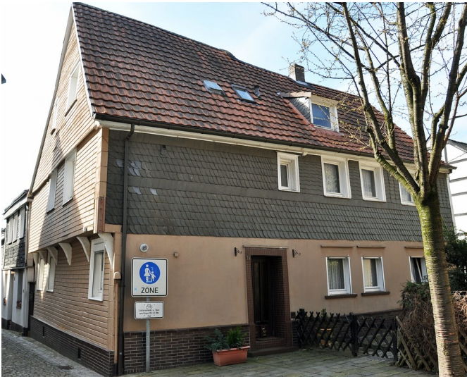
Fachwerkwohnhaus Kaiserstraße 12 in Essen Kettwig Fotograf/Urheber: Buchholz, Karl-Heinz
