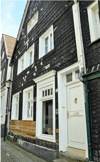
Fachwerkwohnhaus Kaiserstraße 7 in Essen Kettwig Fotograf/Urheber: Buchholz, Karl-Heinz
