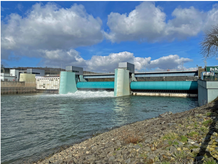
Stauwehr Baldeneysee Fotograf/Urheber: Karl Peter Wiemer
