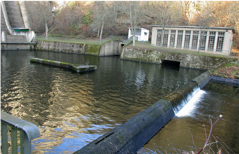
Wassertechnische Anlagen der Oleftalsperre bei Hellenthal (2016). Fotograf/Urheber: Franz-Josef Knöchel
