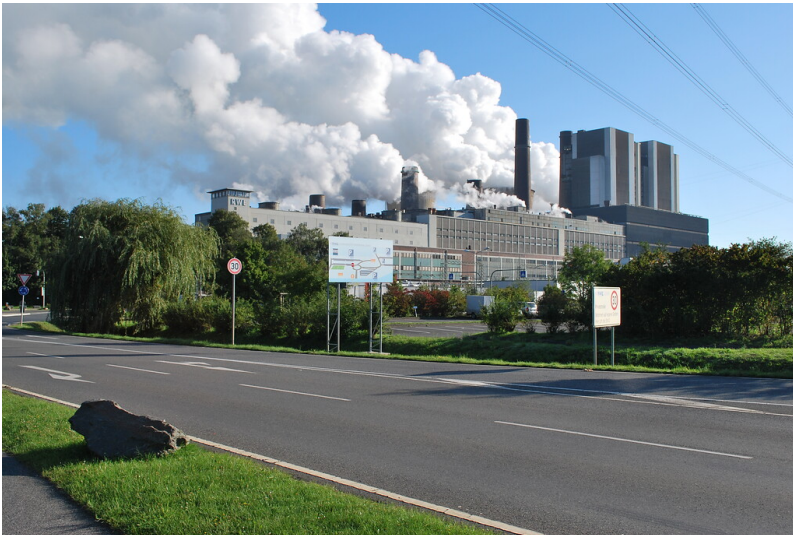
Braunkohlekraftwerk Weisweiler (RWEL) mit den zwei jüngsten Kraftwerksblöcken von 2006 (2015) Fotograf/Urheber: Martina Gelhar
