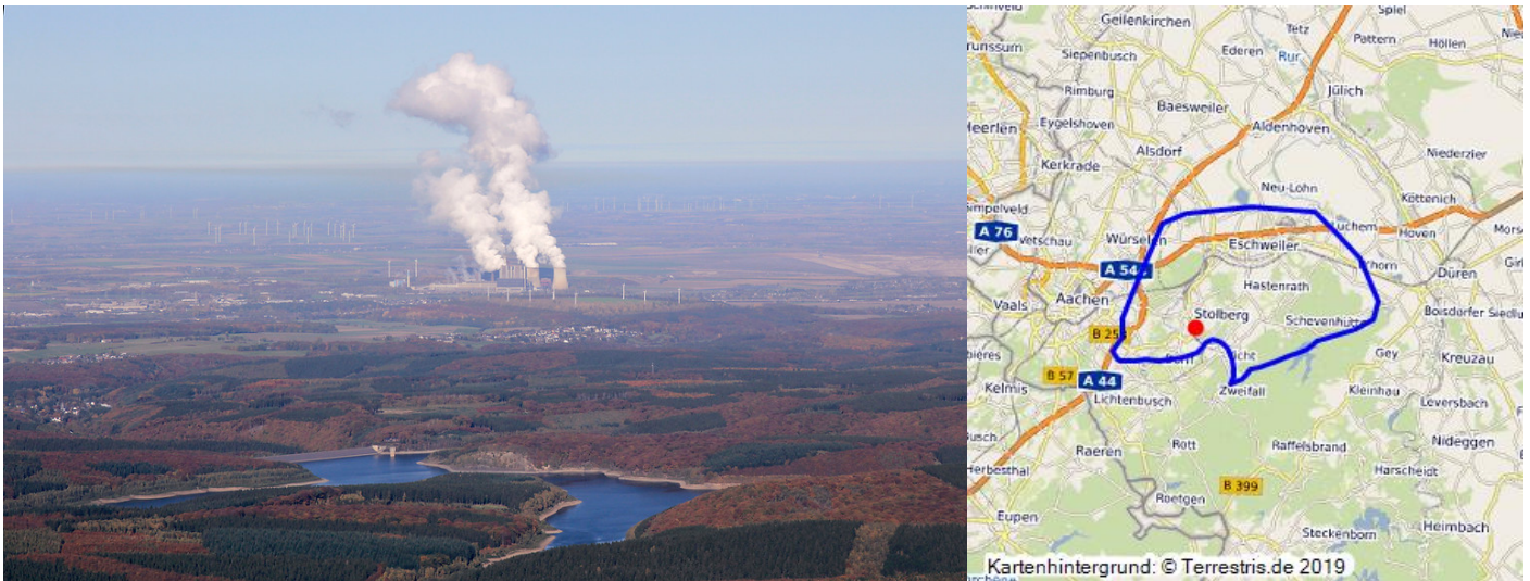
Wehebachtalsperre und Kraftwerk Weisweiler (2016) Fotograf/Urheber: Andreas Schmickler
