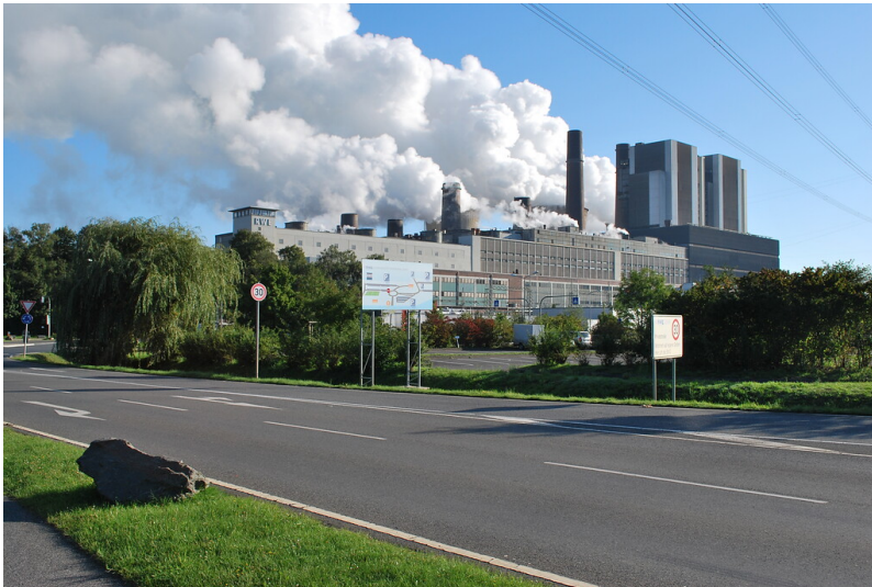
Braunkohlkraftwerk Weisweiler (RWE) mit den zwei jüngsten Kraftwerksblöcken von 2006 (2015) Fotograf/Urheber: Martina Gelhar
