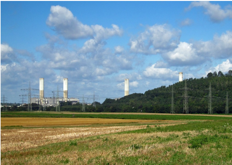
Braunkohlekraftwerk Frimmersdorf I und II (2014) Fotograf/Urheber: Knöchel, Franz-Josef
