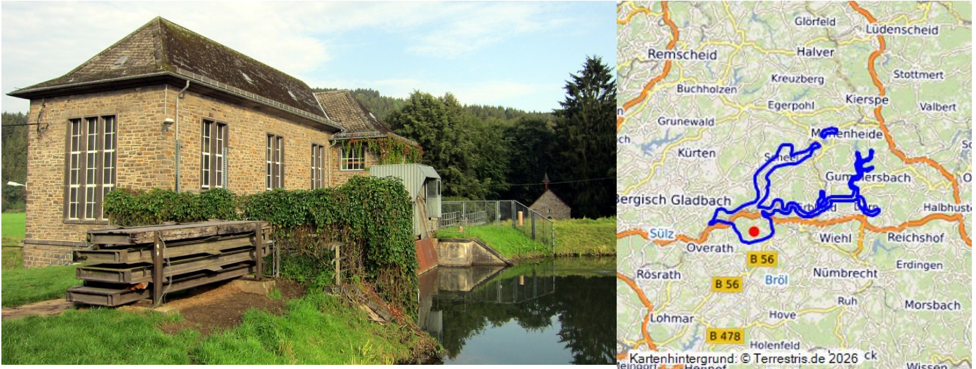
Betriebsgebäude und Wehranlage des Agger-Wasserkraftwerks Ehreshoven im heutigen Ortsteil Engelskirchen-Loope (2011). Fotograf/Urheber: Franz-Josef Knöchel
