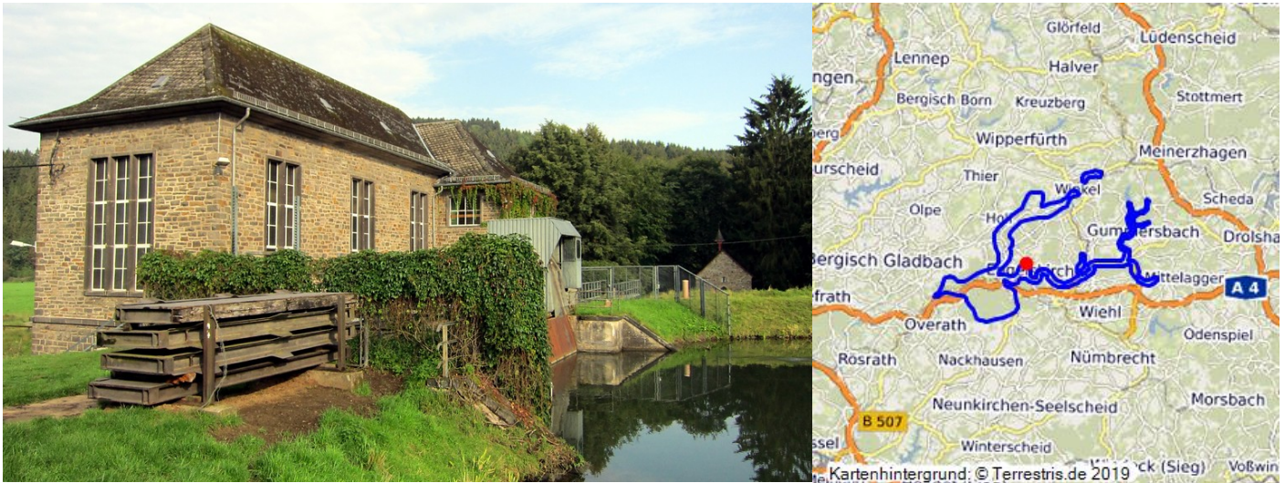
Betriebsgebäude und Wehranlage des Agger-Wasserkraftwerks Ehreshoven im heutigen Ortsteil Engelskirchen-Loope (2011). Fotograf/Urheber: Franz-Josef Knöchel
