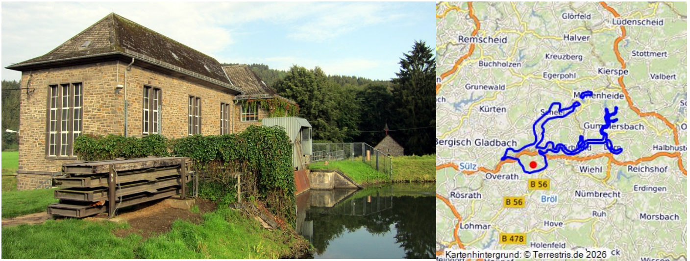
Betriebsgebäude und Wehranlage des Agger-Wasserkraftwerks Ehreshoven im heutigen Ortsteil Engelskirchen-Loope (2011). Fotograf/Urheber: Franz-Josef Knöchel
