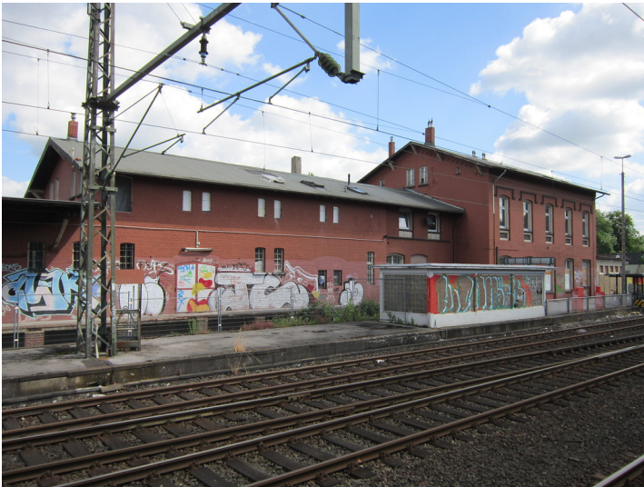
Das Empfangsgebäude (rechts) und links den Güterschuppen des Bahnhofes Gerresheim, von der Bahnseite aus gesehen (2012) Fotograf/Urheber: Weber, Claus
