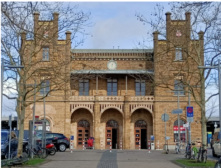
Bahnhof Minden, Empfangsgebäude (2026) Fotograf/Urheber: Claus Weber
