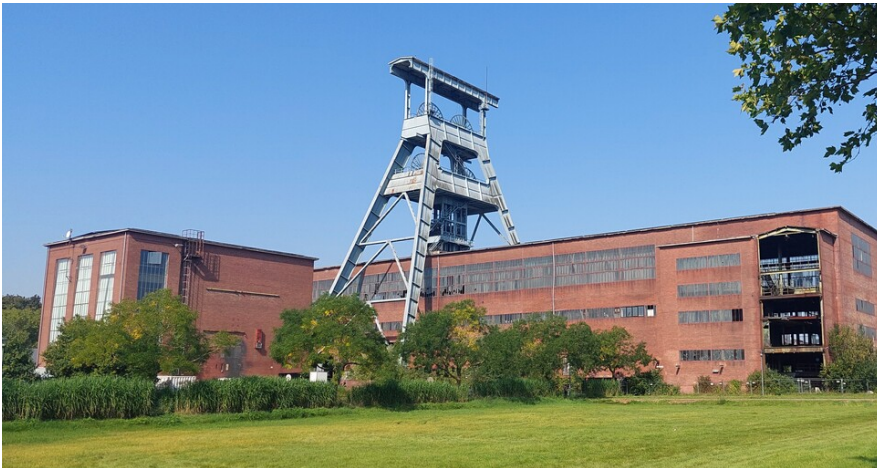
Förderturm (Doppelbock-Fördergerüst über Schacht 7) und Gebäude der Zeche Ewald in Herten (2023). Fotograf/Urheber: Franz-Josef Knöchel
