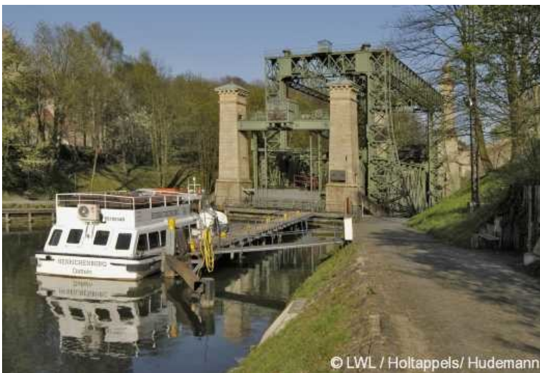
Schiffshebewerk Henrichenburg in Waltrop Fotograf/Urheber: Hudemann; Holtappels
