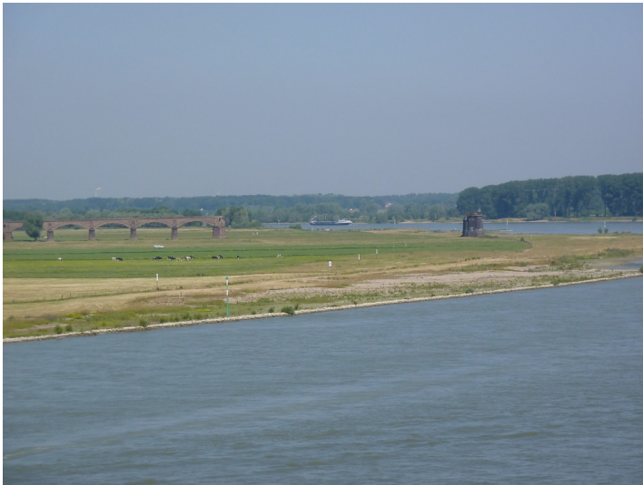
Reste der ehemals längsten Rheinbrücke aus den 1870er Jahren bei Wesel (2010) Fotograf/Urheber: Kleifeld, Helge
