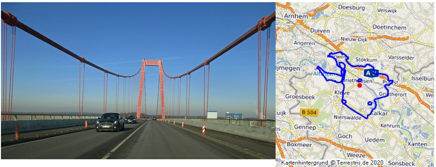
Fahrt über die Rheinbrücke von Kleve nach Emmerich, Blick auf den tragenden Pylon auf der Emmericher Seite (2017). Fotograf/Urheber: Franz-Josef Knöchel
