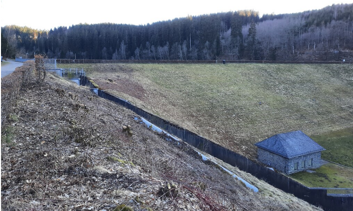
Staudamm der Perlenbachtalsperre (2022) Fotograf/Urheber: Martina Gelhar
