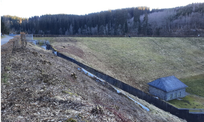
Staudamm der Perlenbachtalsperre (2022) Fotograf/Urheber: Martina Gelhar
