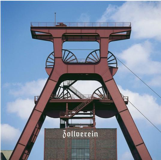
Fördergerüst der Zeche Zollverein 12 mit Fördergerüstkopf und den beiden Seilscheibenbühnen im Detail (2008).
