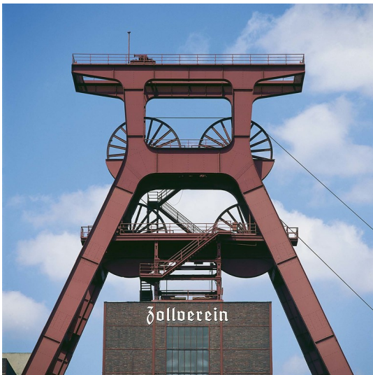
Fördergerüst der Zeche Zollverein 12 mit Fördergerüstkopf und den beiden Seilscheibenbühnen im Detail (2008). Fotograf/Urheber: Manfred Steinhoff
