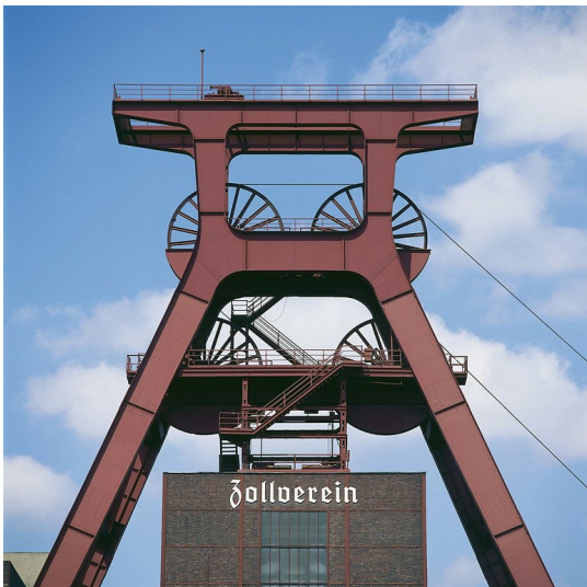
Fördergerüst der Zeche Zollverein 12 mit Fördergerüstkopf und den beiden Seilscheibenbühnen im Detail (2008). Fotograf/Urheber: Steinhof, Manfred
