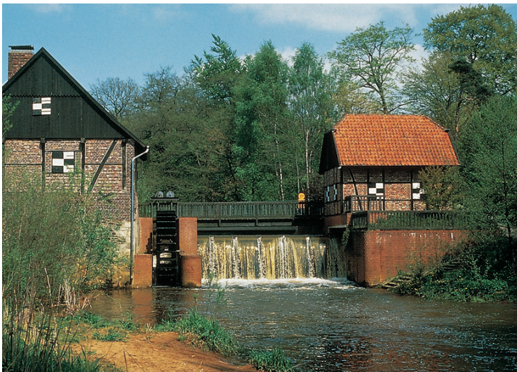
Sythener Wassermühle mit dem Stauwehr (2002) Fotograf/Urheber: Naturpark Hohe Mark
