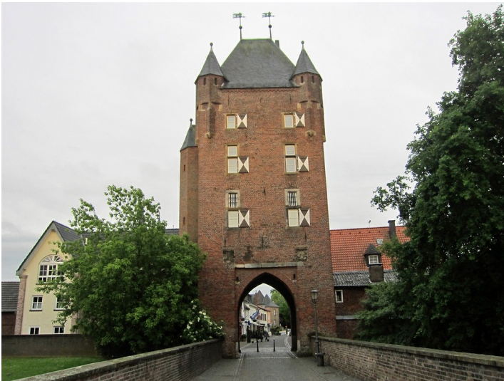
Innerer Torbau des 1393 erbauten Doppeltors "Klever Tor" in Xanten von der stadtaußeren Seite aus (2013). Fotograf/Urheber: Knöchel, Franz-Josef
