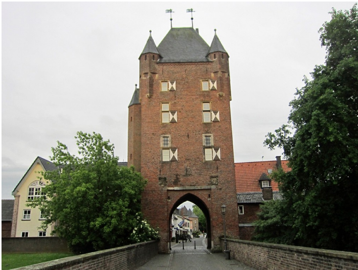
Innerer Torbau des 1393 erbauten Doppeltors "Klevertor" in Xanten von der stadtaußeren Seite aus (2013). Fotograf/Urheber: Knöchel, Franz-Josef
