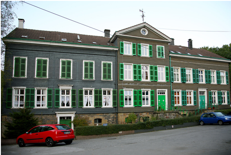
Das zweigeschossige verschieferte Wohnhaus in Vogelsmühle ist denkmalgeschützt (2008) Fotograf/Urheber: Ulla Anne Giesen
