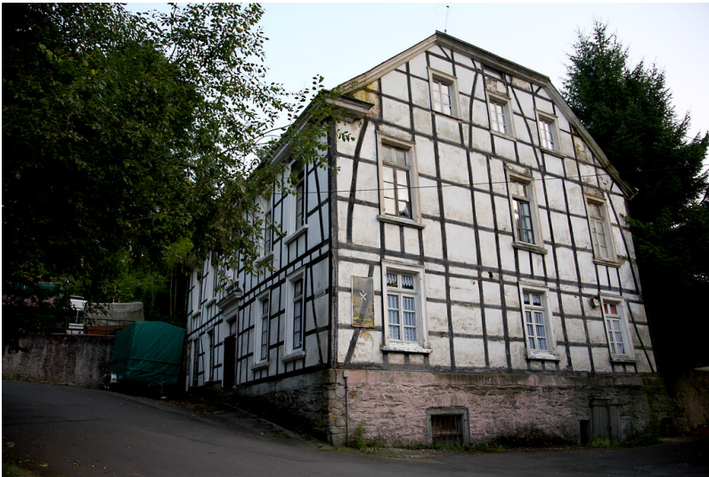
Ehemalige Gaststätte in Vogelsmühle (2008) Fotograf/Urheber: Ulla Anne Giesen
