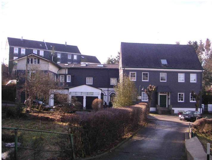
Die verschieferte Gebäudegruppe in Krebsöge war wohl einst ein Erholungsheim einer Wuppertaler Firma (2008) Fotograf/Urheber: Beate Lange
