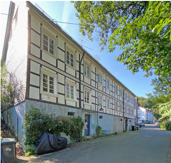
Arbeiterwohnhaus Wupperstraße 19-21 in Dahlerau (2021) Fotograf/Urheber: Dietfried Auras
