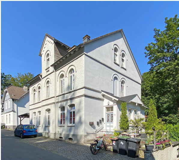
Gebäude Wupperstraße 4 in Dahlerau (2021) Fotograf/Urheber: Dietfried Auras
