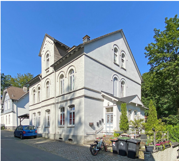
Gebäude Wupperstraße 4 in Dahlerau (2021) Fotograf/Urheber: Dietfried Auras
