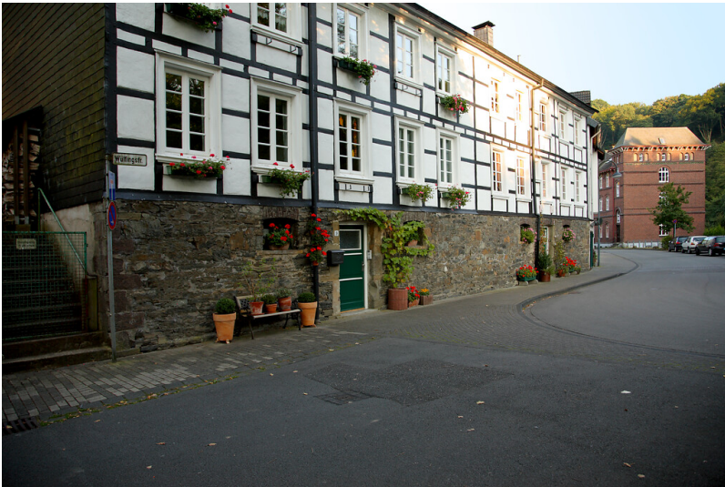
Arbeiterwohnhaus Wülfingstraße 9-11 in Dahlerau mit Bruchsteinsockelgeschoss und Fachwerk in den Obergeschossen (2008) Fotograf/Urheber: Ulla Anne Giesen
