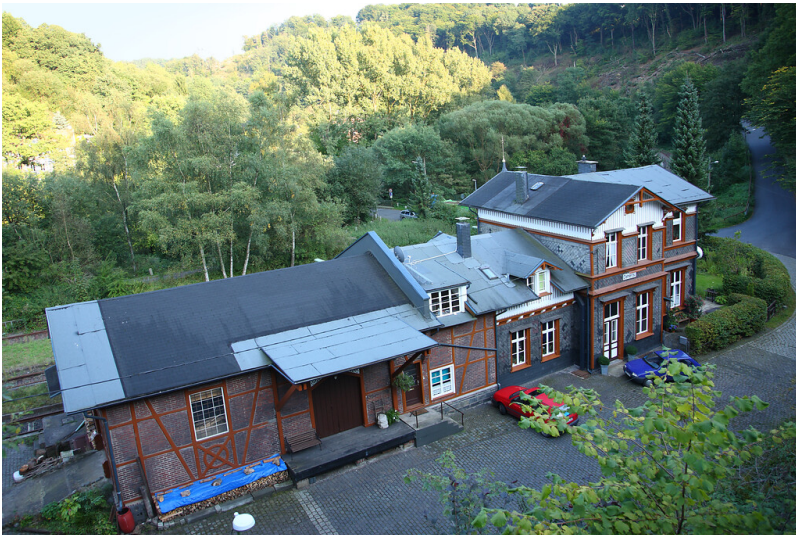
Der Bahnhof Dahlerau ist ein zweieinhalbgeschossiger mehrteiliger Fachwerkbau(2008) Fotograf/Urheber: Ulla Anne Giesen
