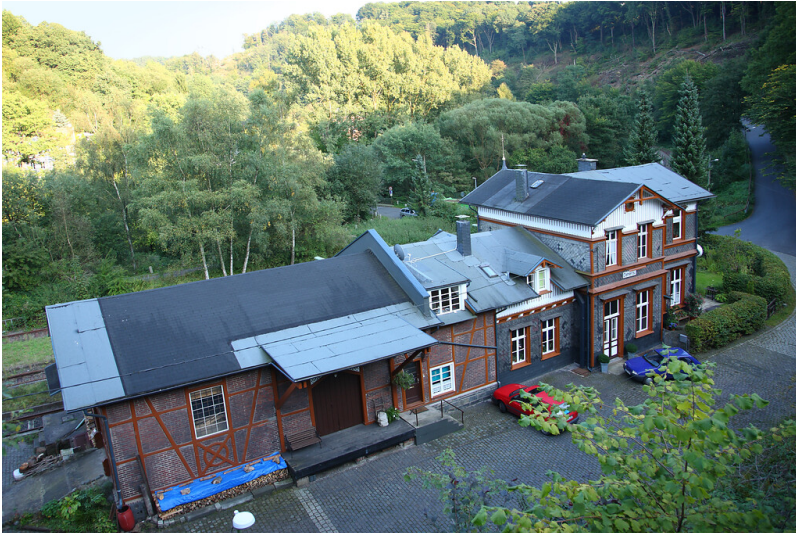
Der Bahnhof Dahlerau ist ein zweieinhalbgeschossiger mehrteiliger Fachwerkbau(2008) Fotograf/Urheber: Ulla Anne Giesen
