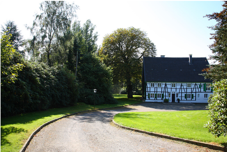
Denkmalgeschütztes Fachwerkhaus von 1777 in Vor der Mark (2008) Fotograf/Urheber: Ulla Anne Giesen
