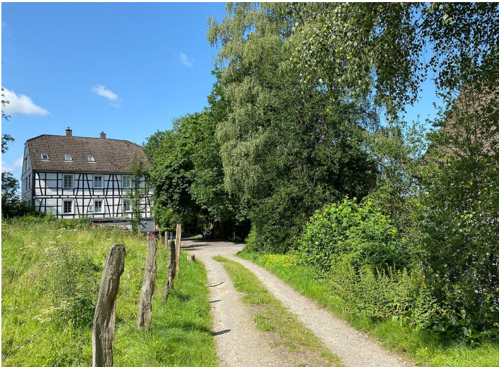
Fachwerkhaus Herkingrade 21 in Radevormwald (2021) Fotograf/Urheber: Dietfried Auras
