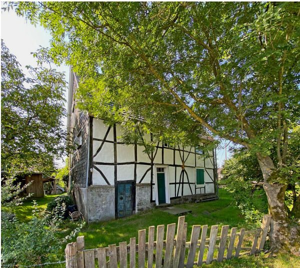
Fachwerkhaus Vorm Baum 9 in Radevormwald (2021) Fotograf/Urheber: Dietfried Auras
