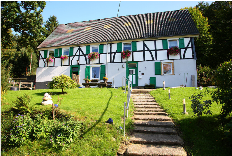
Das Wohnstallhaus in Milspe verfügt über ein Bruchsteingeschoss mit Fachwerkaufbau (2008). Fotograf/Urheber: Ulla Anne Giesen
