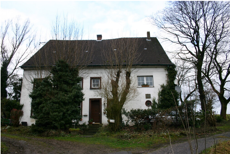
Das Wohnstallhaus in Hürxtal wurde 1744 errichtet und steht unter Denkmalschutz (2008) Fotograf/Urheber: Nicole Schmitz
