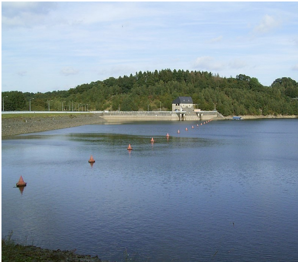
Staudamm der Wuppertalsperre in Radevormwald-Krebsöge (2007) Fotograf/Urheber: Frank Vincentz
