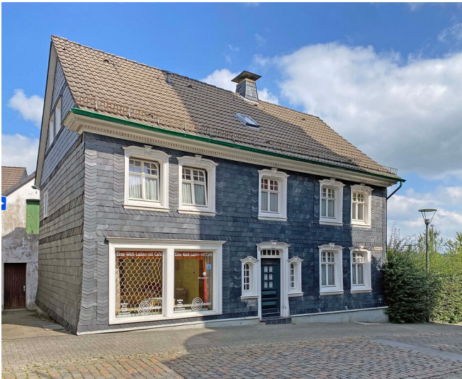
Wohnhaus Oststraße 19 in Radevormwald (2021) Fotograf/Urheber: Dietfried Auras
