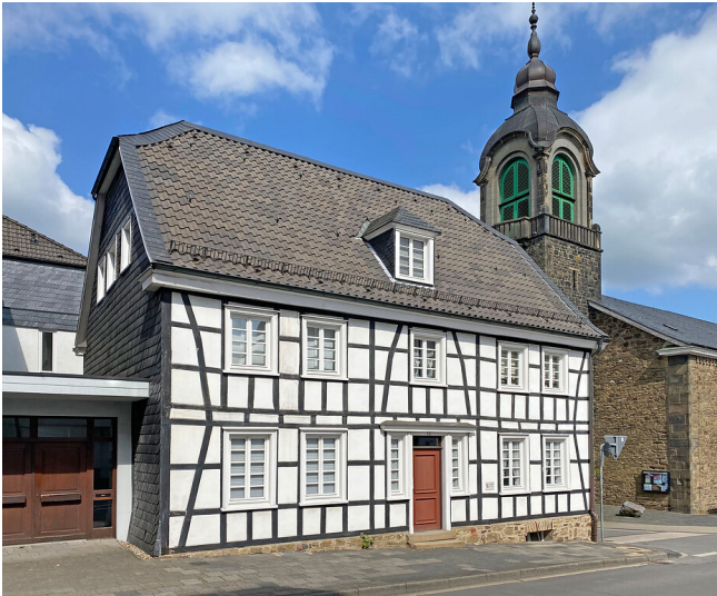
Wohnhaus Uelfestraße 11 in Radevormwald (2021) Fotograf/Urheber: Dietfried Auras
