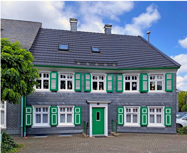
Wohnhaus Oststraße 5 in Radevormwald (2021) Fotograf/Urheber: Dietfried Auras
