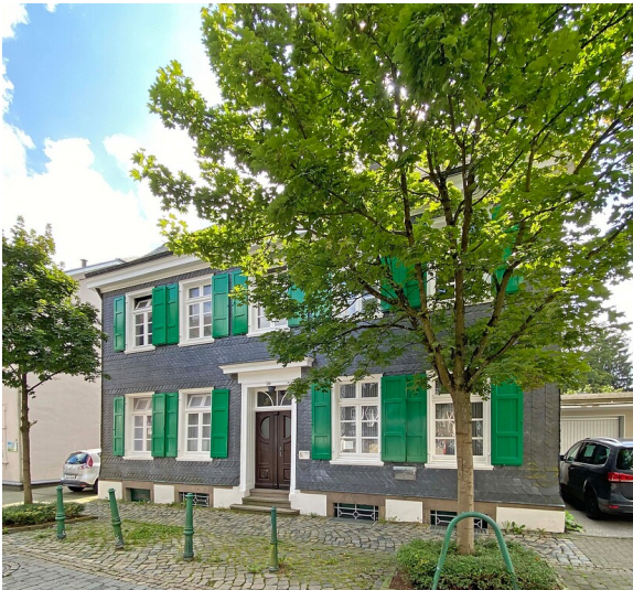
Wohnhaus Grabenstraße 20 in Radevormwald (2021) Fotograf/Urheber: Dietfried Auras
