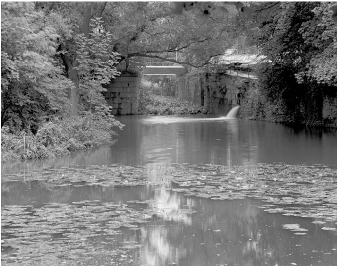
Neukircher Schleuse Fotograf/Urheber: LVR-ABR
