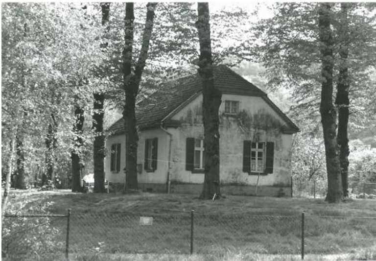
Schleusenwärterhaus der Papiermühlenschleuse in Essen-Werden Fotograf/Urheber: UDB Essen
