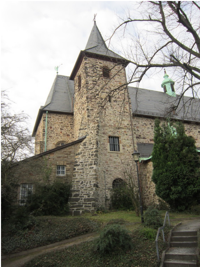
Essen, Karmelitinnenkirche in Stoppenberg. Blick auf den südlichen Turm des Westwerkes (2017) Fotograf/Urheber: Claus Weber
