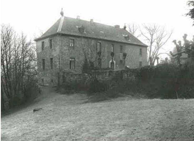
Haus Heisingen Fotograf/Urheber: LVR-ABR
