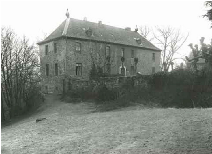
Haus Heisingen Fotograf/Urheber: LVR-ABR
