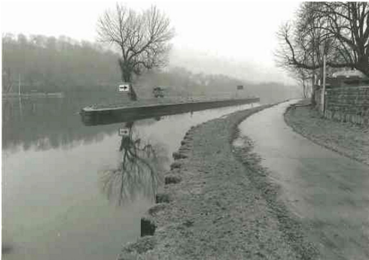
Schleusenammer der Rotmühlenschleuse in Essen-Heisingen Fotograf/Urheber: LVR-ABR
