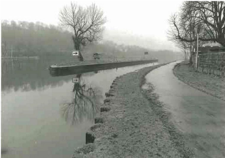
Schleusenammer der Rotmühlenschleuse in Essen-Heisingen Fotograf/Urheber: LVR-ABR
