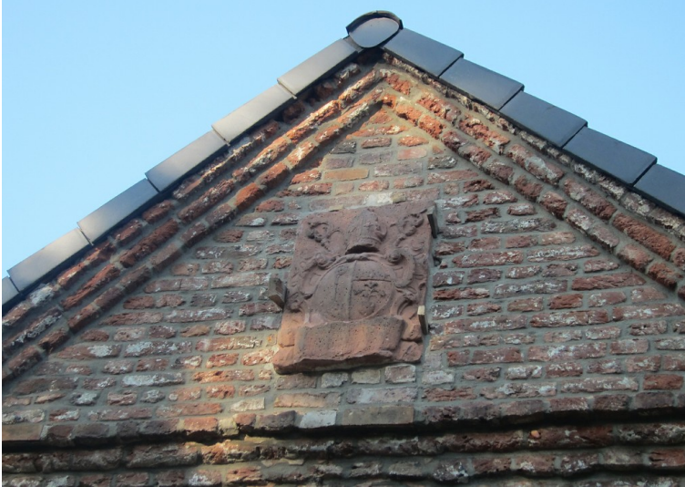
Das Wappen der Abtei Altenberg im Giebel des Zufahrtstores des Hermeshofes bei Rommerskirchen (2014) Fotograf/Urheber: Franz-Josef Knöchel
