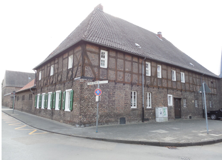
Bongartzhof in Köln-Flittard (2020) Fotograf/Urheber: Frederic Tempelaars
