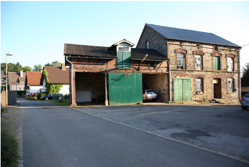
Blick auf die Brennerei in Herkingrade von Norden (2008) Fotograf/Urheber: Ulla Anne Giesen
