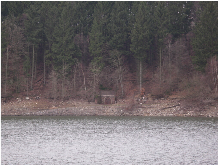
Stollenmundloch an der Wuppertalsperre (2008) Fotograf/Urheber: Nicole Schmitz
