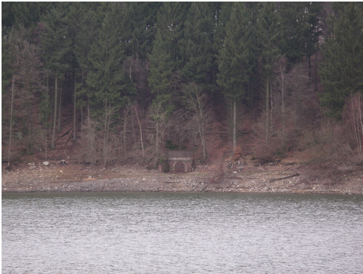
Stollenmundloch an der Wuppertalsperre (2008) Fotograf/Urheber: Nicole Schmitz
